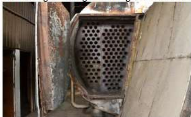
Slika 4. Izgled unutrašnjosti kotla
