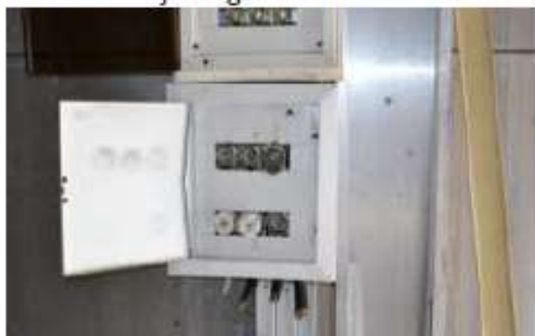
Slika 17. Elektro ormarić (skinuti kablovi)
