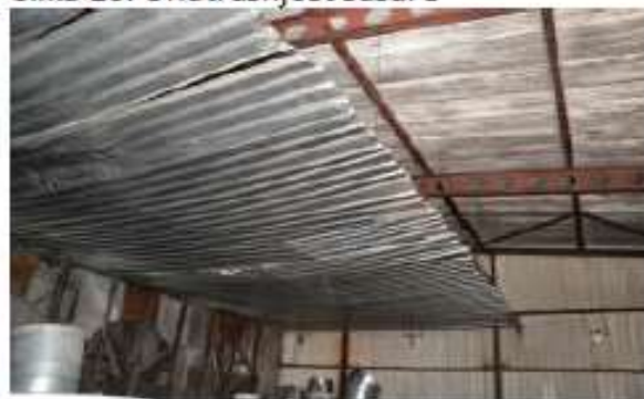
Slika 12. Urušen dio krovnog lima
