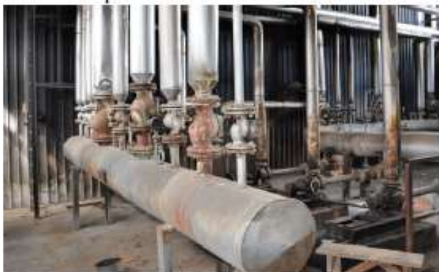
Slika 5. Razdjelnici u kotlovnici
